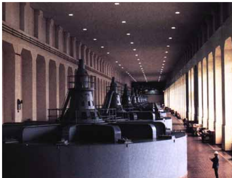
Εικ. 5.2 Ηλεκτρογεννήτριες υδροηλεκτρικού σταθμού. Η παραγωγή ηλεκτρικής ενέργειας στηρίζεται στο φαινόμενο της επαγωγής.
